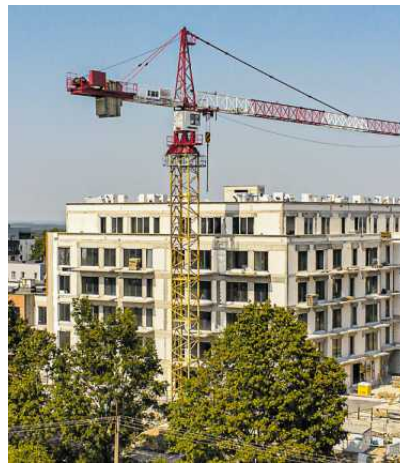
• Budowa domu w Zielonej Górze
