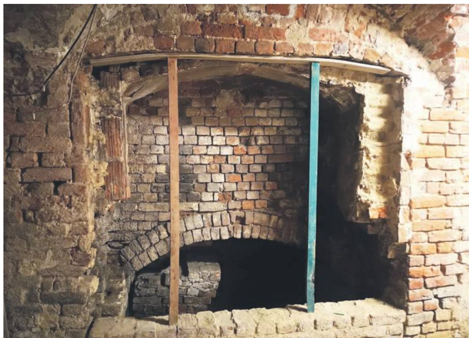
Widać, że to miejsce przebudowywano wiele razy
