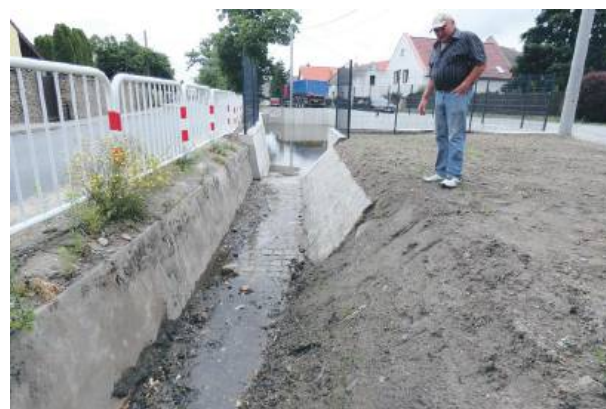
Rów i skarpa przed ujściem do osadnika
