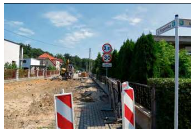
Przebudowa już się zaczęła.
