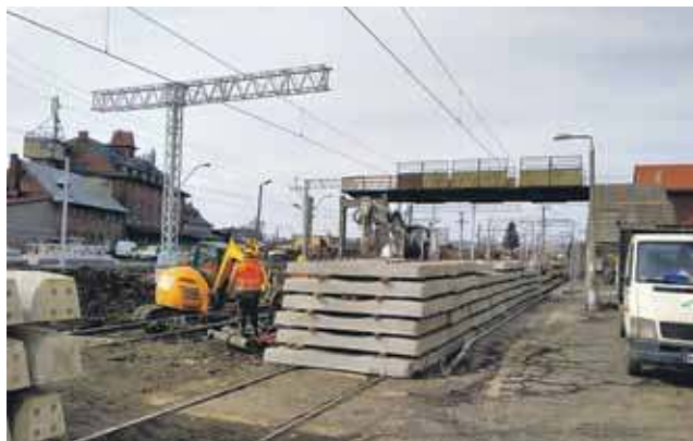
Rozebrana część kładki, zdjęte tory, wkrótce nowa sieć - trwają prace na nowotarskim dworcu.
