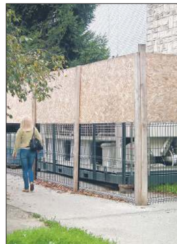
Agregaty zabezpieczono płytami.
