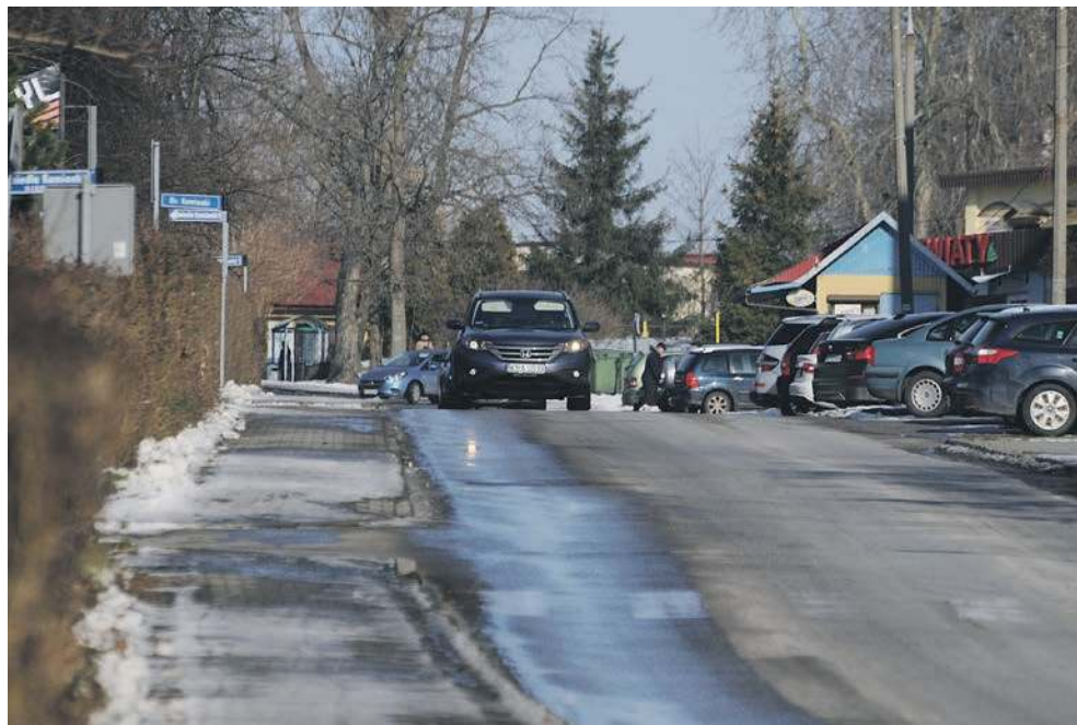
Zostanie wyremontowana ul. Skłodowskiej-Curie w Alwerni
