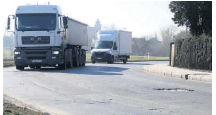
Na odcinku drogi krajowej od Wiązowa do Starego Wiązowa kierowcy muszą się mierzyć z wieloma dziurami i nierównościami w nawierzchni
