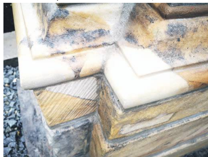
Brakujące elementy uzupełniono
