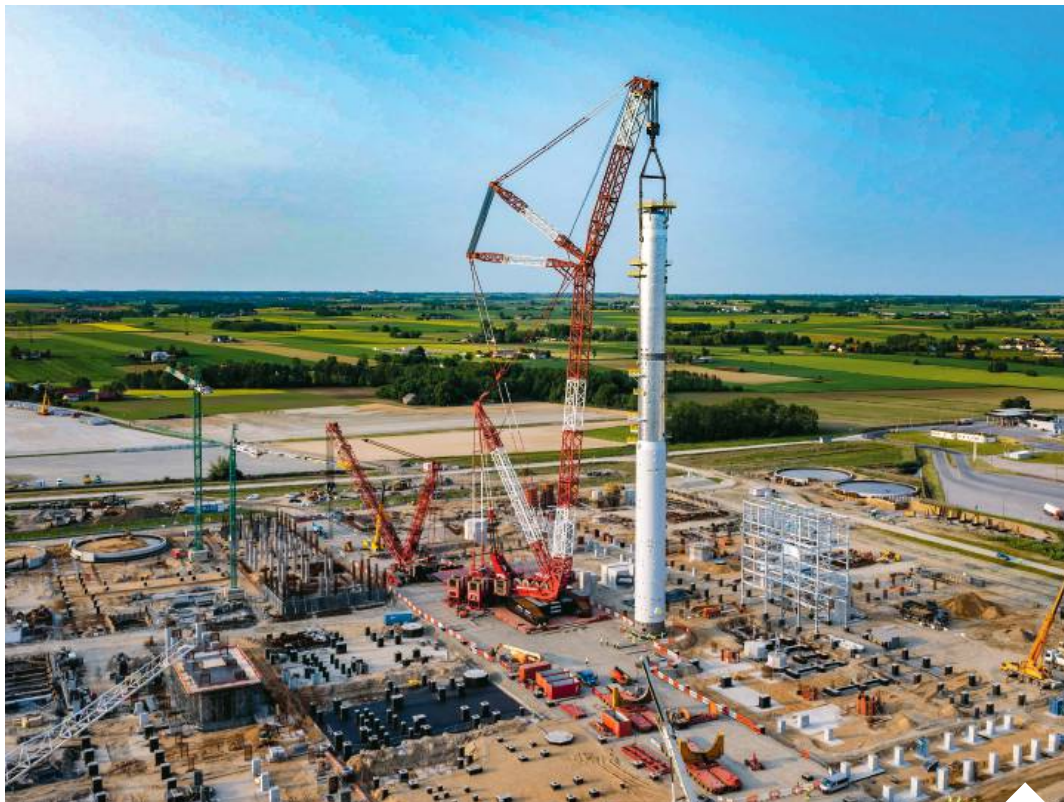
W tym roku na realizację projektów zwiększających bezpieczeństwo energetyczne i niezależność surowcową Polski oraz regionu Orlen przeznacza rekordowe 36 mld zł | fot. mat. pras./d
