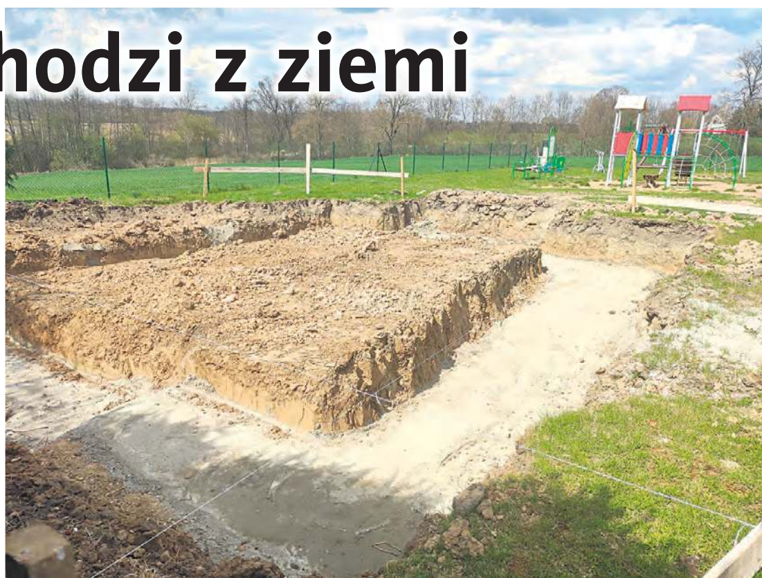
Świetlica wychodzi z ziemi.
