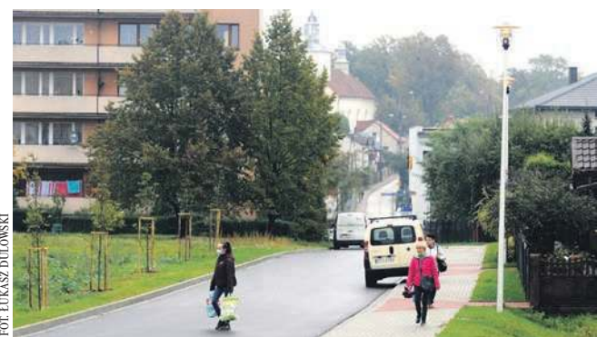
Kościelna na osiedlu Południe w Chrzanowie po zakończeniu prac
