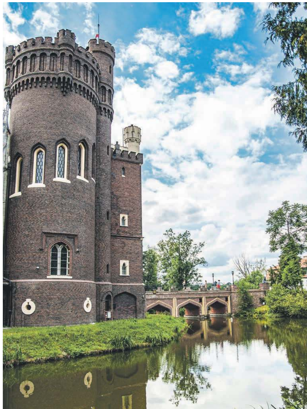
Widok na jedną z zamkowych baszt, fosę i most prowadzący do wejścia
