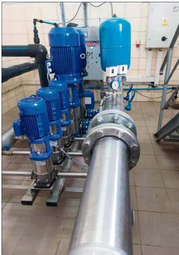
Tak prezentuje się wnętrze przepompowni po przeprowadzonej modernizacji.
