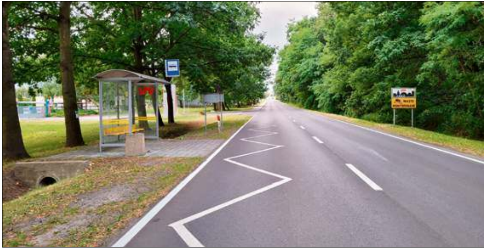
Teraz droga na i z przystanku będzie bardziej bezpieczna.
