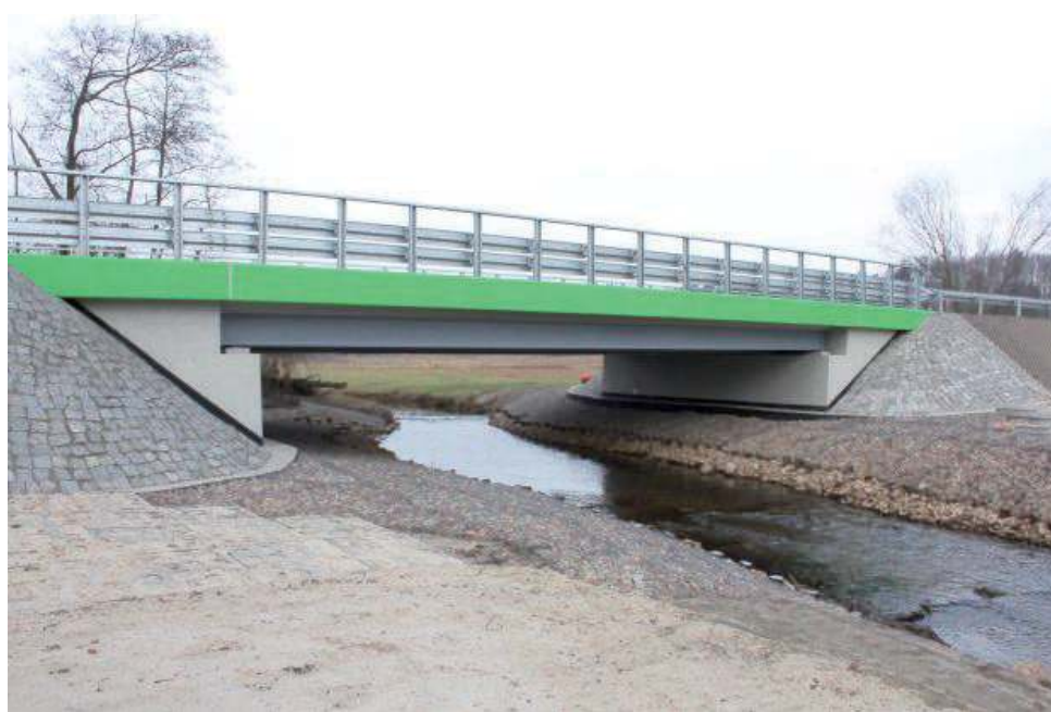
Jezdnia na nowym moście w Sarnowie ma 7 m szerokości. Do tego z myślą o pieszych wykonano wygodny chodnik
