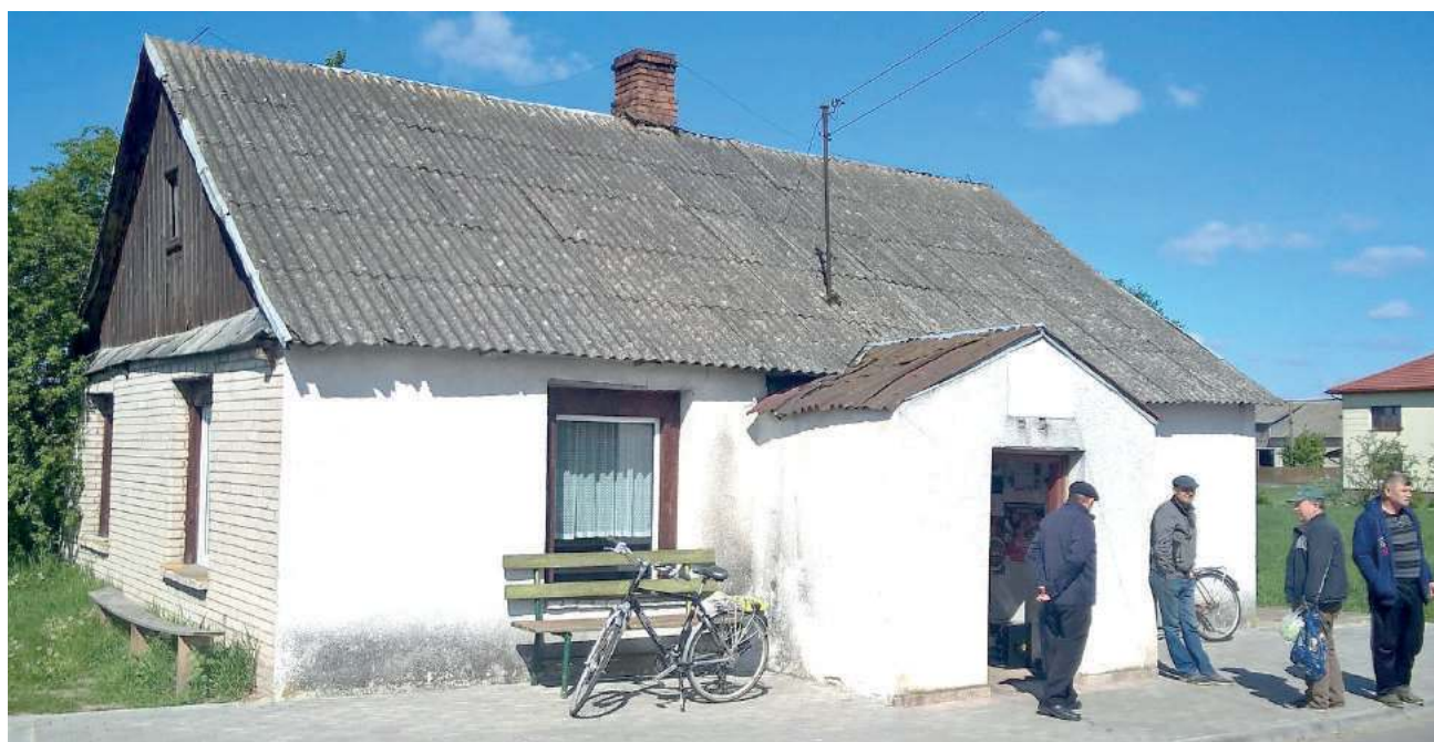
W budynku oprócz tzw. ganku, były trzy pomieszczenia: sklep plus magazyn i od południowej strony pomieszczenie na szkołę
