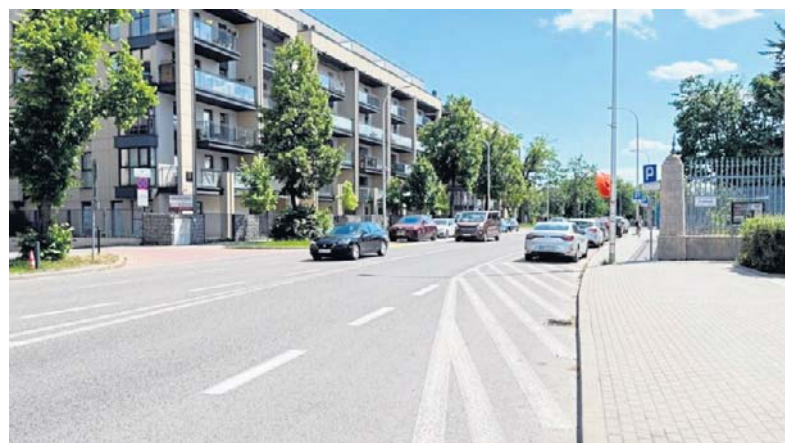
Od 16 września utrudnienia na Ściegiennego - remont obejmie odcinek od okolic WDK do skrzyżowania z Małą Zgodą i Barabasza.
