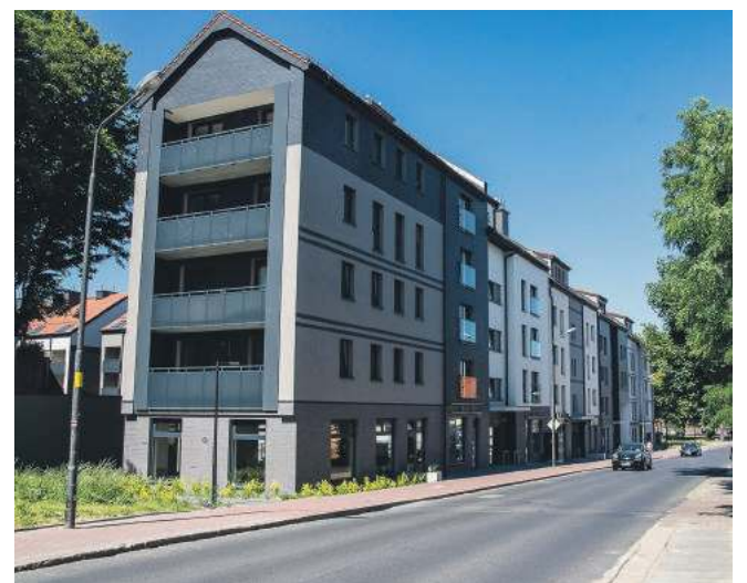
Doraźne schronienia znajdują się także w budynkach osiedla "Stara Mleczarnia"
