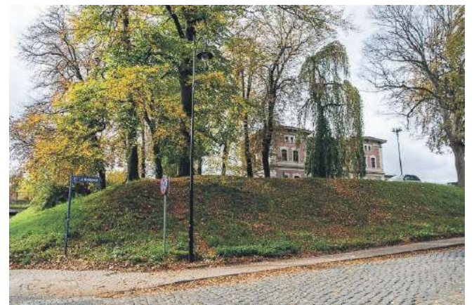
Dawne schrony przeciwlotnicze przy trzebnickim dworcu kolejowym zostały zakwalifikowane jako doraźne schronienia
