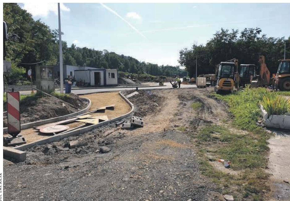
(E) Prace przy dawnym kamieniołomie w Miękinii idą pełną parą
