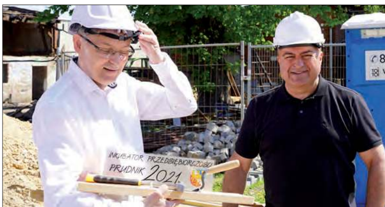
Wicestarosta Janusz Siano i kierownik budowy Janusz Adamów na placu budowy
