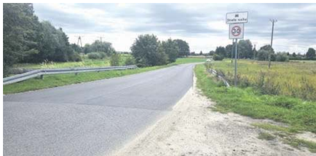
Ścieżka pieszo-rowerowa ma powstać przy drodze ulgi od mostu na Oławce do ul. Kilińskiego
