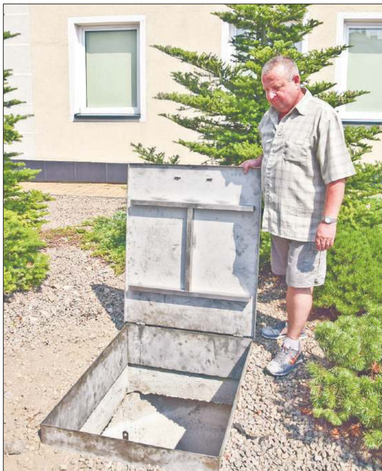
Pracownicy GZK sprawdzają m.in. studzienki kanalizacyjne; na zdjęciu Mirosław Kot, pracownik GZK w Czarnej.
