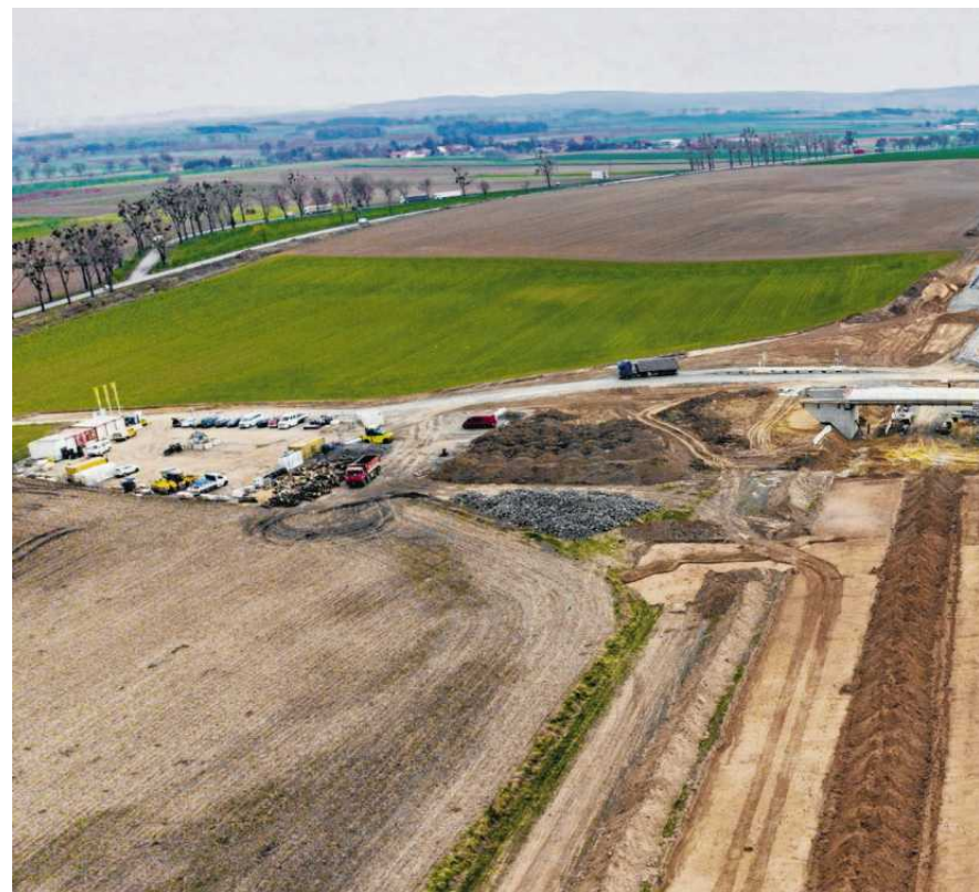
• Budowa drogi ekspresowej S8 na odcinku między Łagiewnikami a Jordanowem
