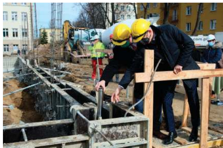
5 marca w fundament powstającej hali sportowej wmurowano symboliczną kapsułę czasu
