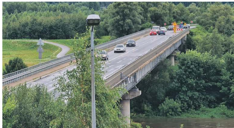
Widok na most w Jankowicach
