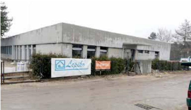
Rozbudowywana szkoła w Kobylance
