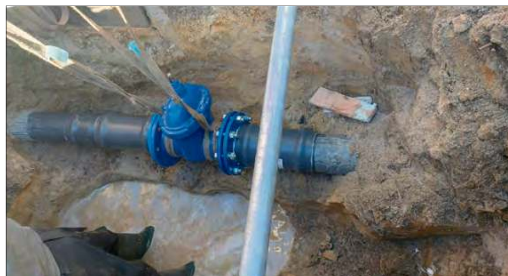
Wymianę przeprowadzono w Serwitucie.
