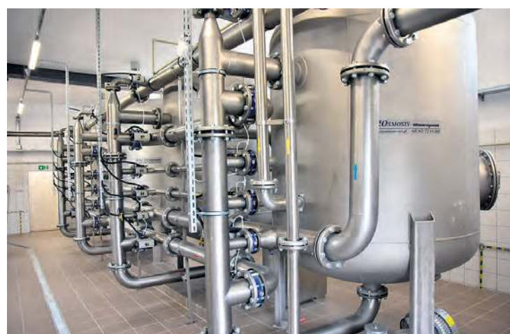
W stacji uzdatniania wody wymieniono praktycznie cały osprzęt.
