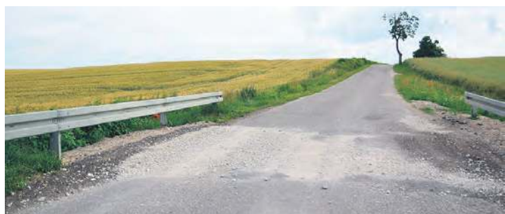
Jeden z wyremontowanych przepustów tymczasowo uzupełniony kruszywem.
