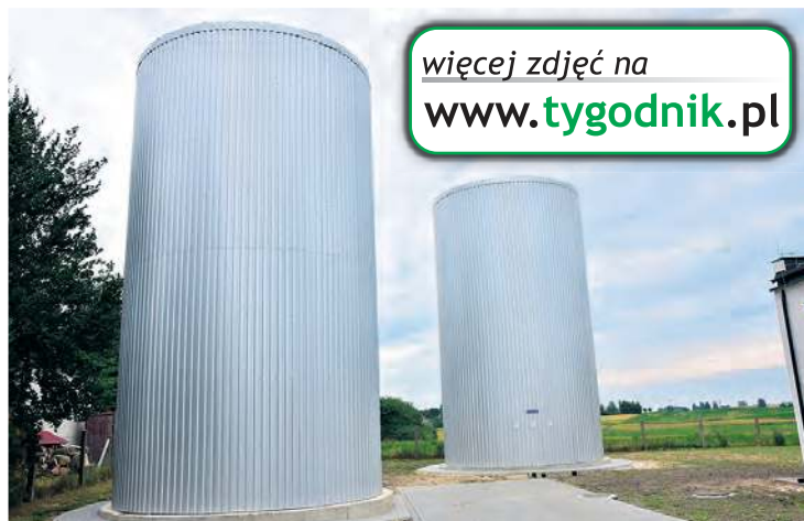
To jedna z najważniejszych inwestycji, czyli dwa zbiorniki retencyjne wody czystej, po 200 m 3 każdy.
