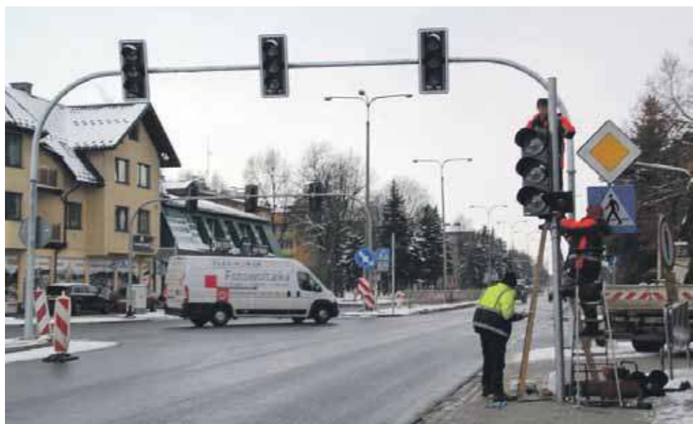
Wtorek. Drogowcy montują kolejne sygnalizatory świetlne.
