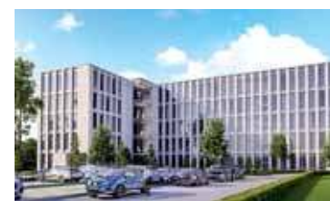
Realizacja Budowy Centrum Administracyjnego
