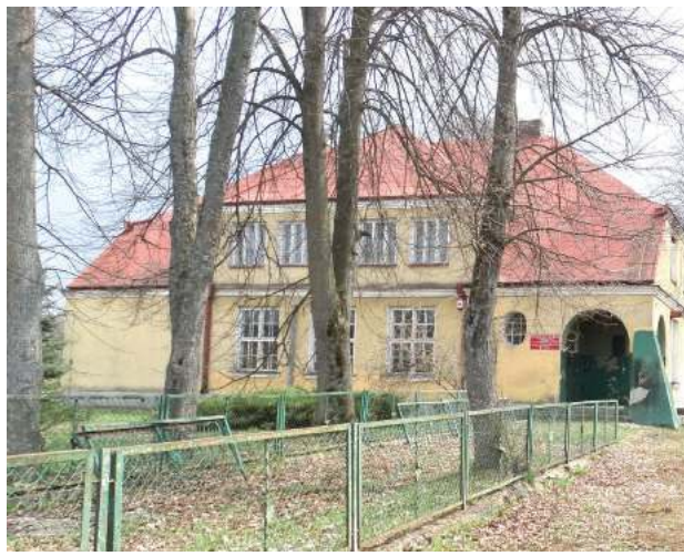
Budynek dawnej szkoły w Osuchach przejdzie gruntowny remont
