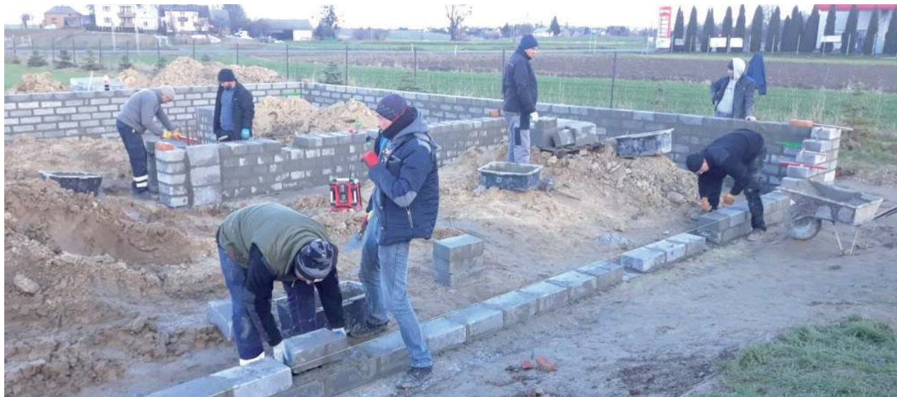
Budowa świetlicy trwa, ale zbiórka także. Inwestycję trzeba doprowadzić do końca
