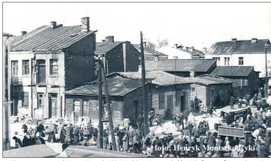
■ W prywatnym archiwum Henryka Moniszki można znaleźć wiele fotografii przedstawiających obiekty, których już nie ma, jak choćby kamienice i drewniane chaty w miejscu, w którym stoi dziś pawilon handlowy i „Biedronka”
