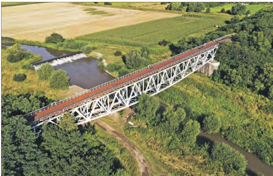
Jeżeli linia zostanie wyremontowana, to z nią monumentalny most kolejowy w Racławicach Śląskich.
