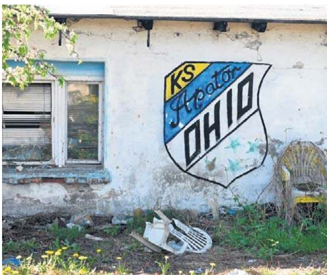
Czas wyburzeń w „Ohio” - rok 2021
