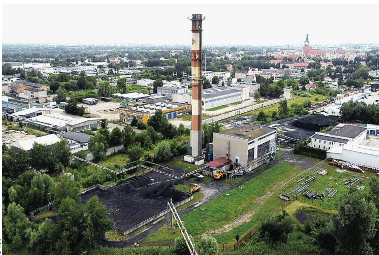
Tuż obok istniejącej ciepłowni przy ul. Dojazdowej miała powstać nowa ekologiczna elektrociepłownia
