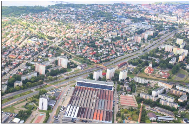
Widok na plockie osiedle Międzytorze z lotu ptaka
