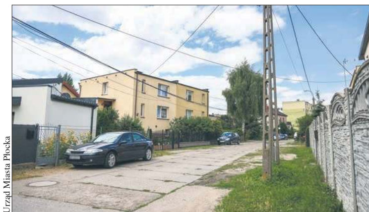
Ulica Gronowa zostanie przebudowana
