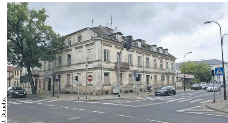
Budynek przy ul. 1 Maja 2 zostanie wyburzony. W jego miejsce powstanie nowy obiekt
