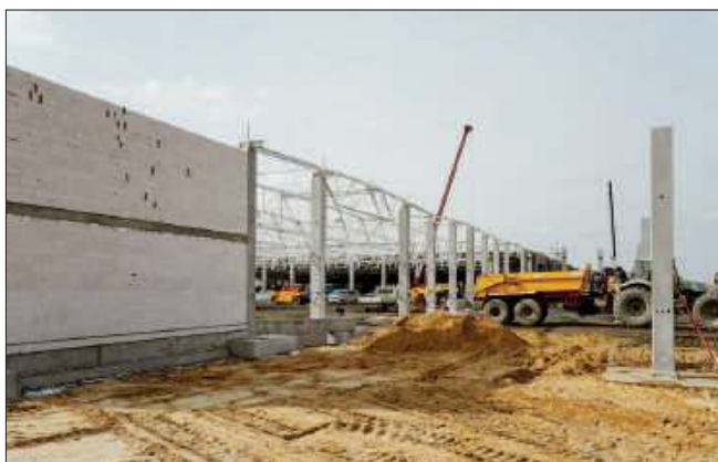
Budowa nowej hali Eko-Okien w Kornicach
