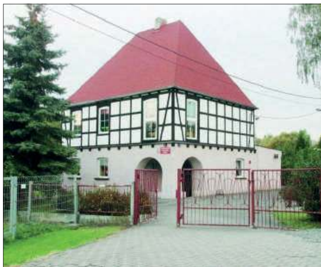
To budynek, w którym jeszcze nie tak dawno funkcjonowało przedszkole. Jeśli radni przystaną na urzędniczy pomysł, teren zostanie wystawiony na wynajem.
