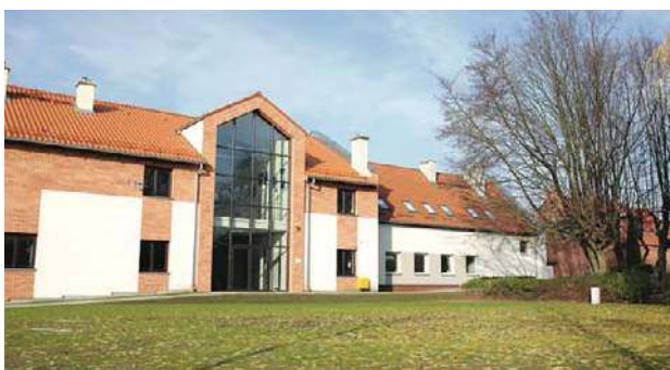
Remont budynków Liceum Sztuk Plastycznych w Gronowie Górnym (źródło: Starostwo Powiatowe w Elblągu)
