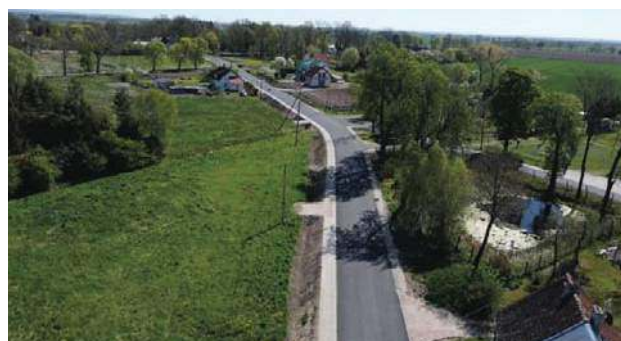
Remont drogi w Fiszewie (źródło: Starostwo Powiatowe w Elblągu)
