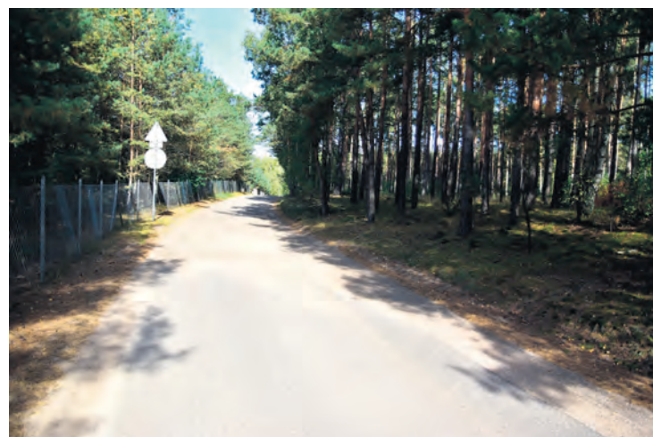
Kolejny odcinek drogi prowadzącej z Wymysłowa do Kiełpina doczeka się przebudowy.
