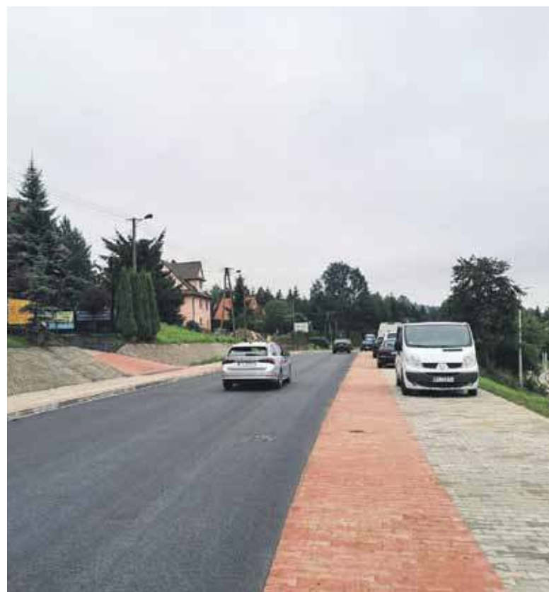
Ulica Zakopiańska jeszcze półtora roku temu w tym miejscu miała głębokie pęknięcie wzdłuż głównej osi.
