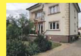
Piętrowy dom w Białej Podlaskiej, z użytkowym poddaszem na działce o powierzchni 929 m 2 , 885 851 172
