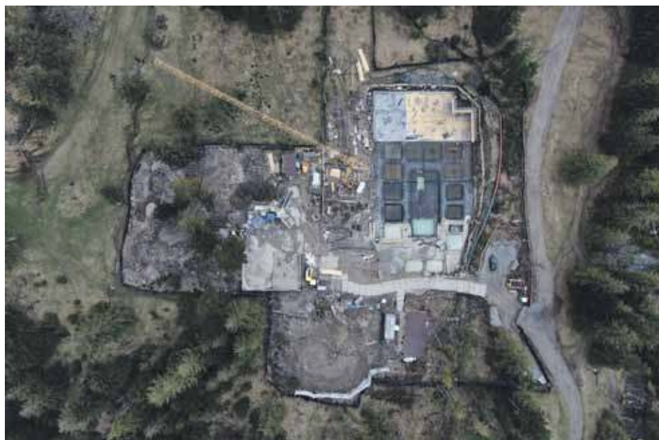
Tak budowa wygląda teraz.
