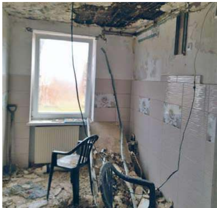
Teraz trzeba wyremontować wnętrze domu
