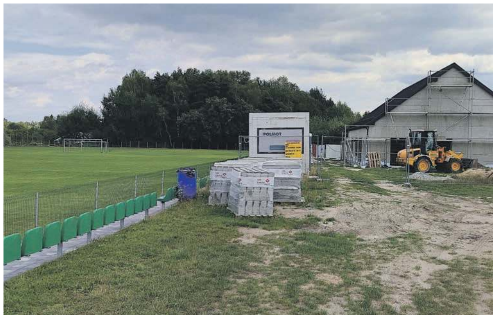
Trwa budowa zaplecza sportowo-socjalnego w Regulicach
