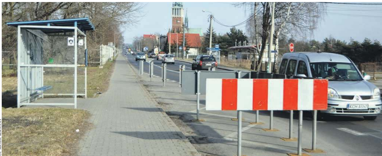
(MK) Odgradzony fragment jezdni koło przystanku autobusowego na ul. Długiej
