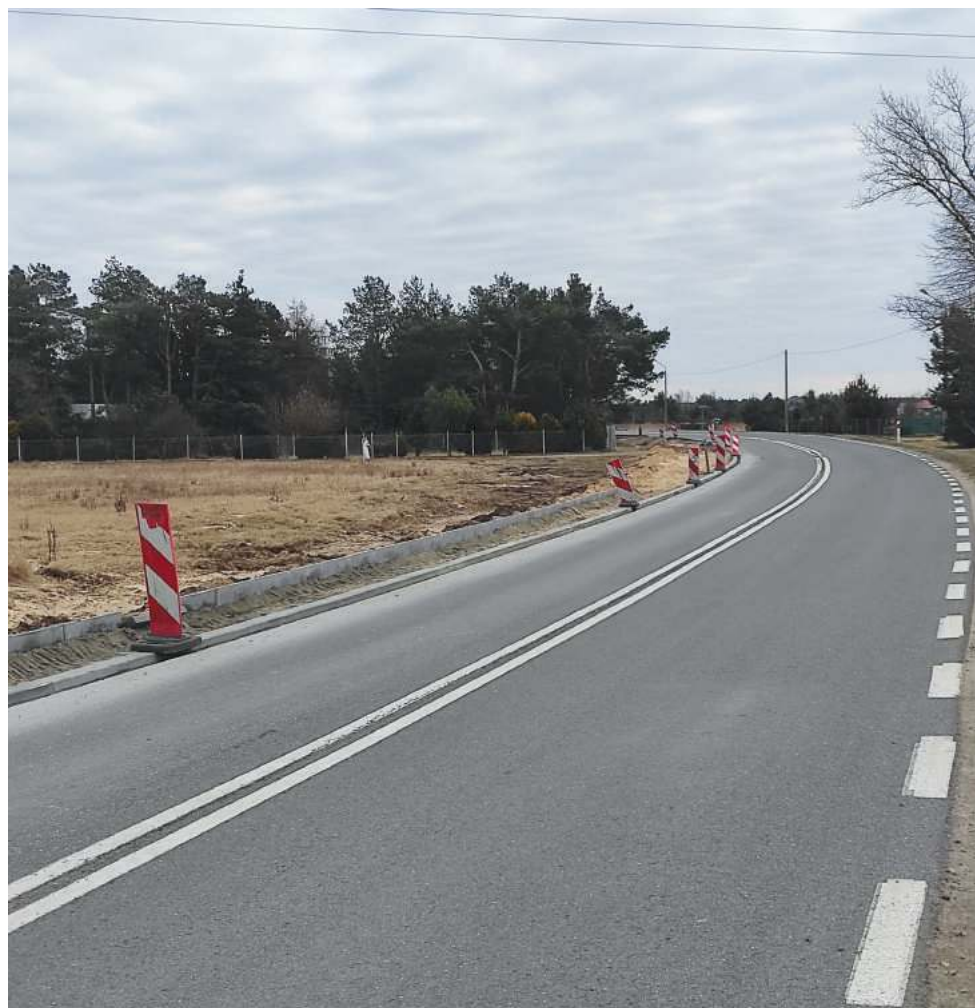
Budowa ciągnie się na całym odcinku inwestycji
