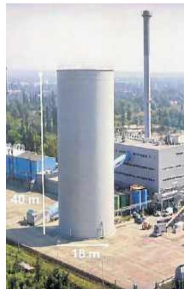
Tak wyglądać ma akumulator ciepła przy OPEC-u
