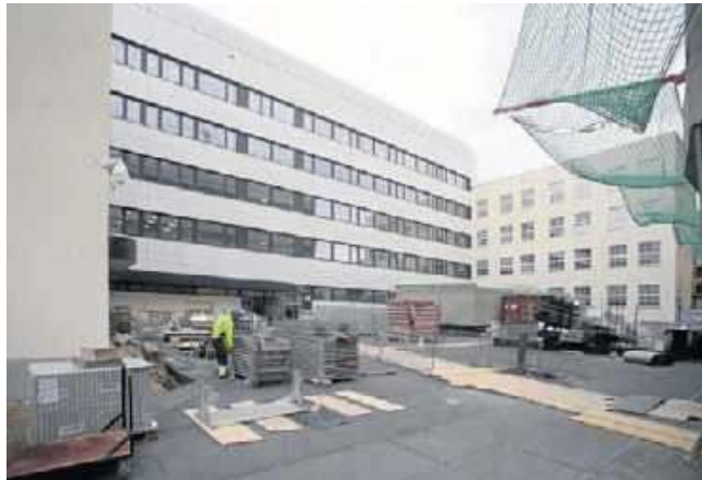
Jeden z dwóch budynków urzędu marszałkowskiego będzie gotowy już za dwa miesiące
