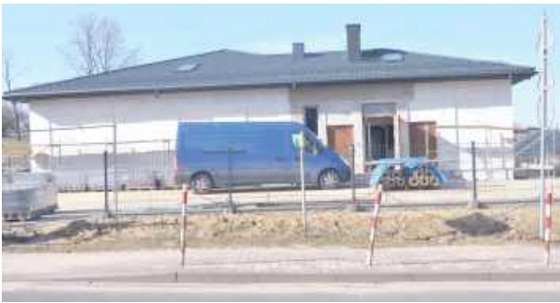
Koszt budowy oraz wyposażenia nowej placówki to łączna kwota około 5,5 miliona złotych. Projekt jest finansowany głównie ze środków zewnętrznych: Polski Ład i Aktywny Maluch
