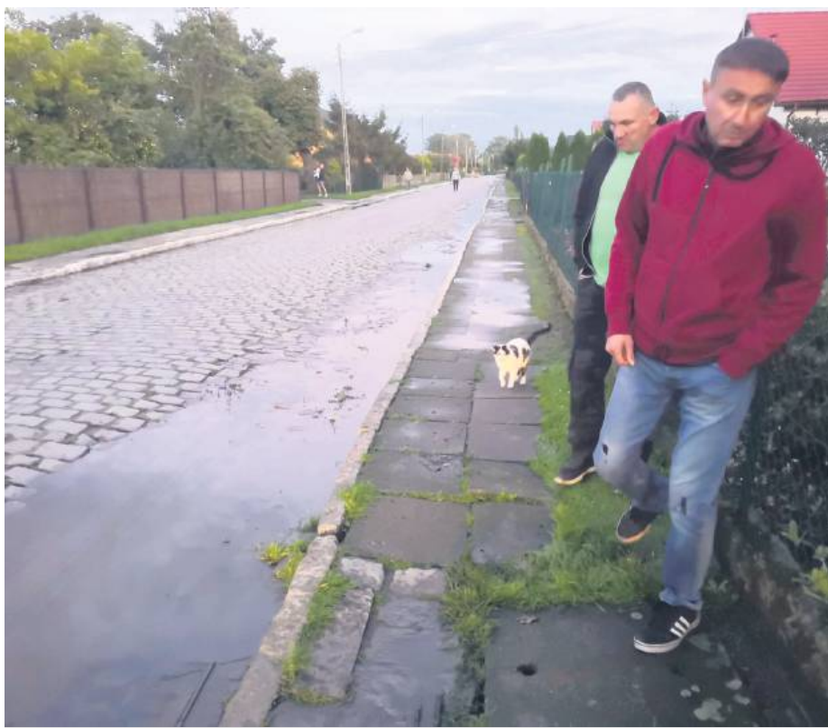
Sołtys Radosław Mossoń (na pierwszym planie) od długiego czasu zabiega o naprawę kanalizacji deszczowej w Witowicach. Na zdjęciu widać, jak wypływająca ze studzienki brudna woda płynie drogą w dół wsi
