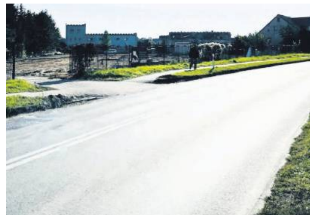
Miejsce prac jest dobrze widoczne z ul. Strzebińskiej
