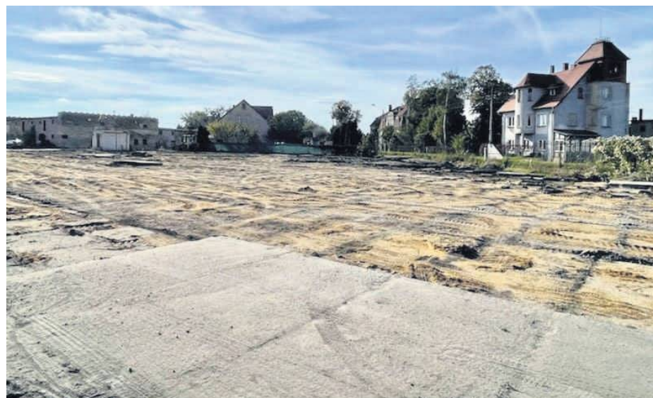
Prace demontażowe nawierzchni na placu po byłym GS-ie są bardzo zaawansowane
