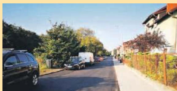
Nowa nawierzchnia na ul. Tęczowej (na zdj.) oraz sąsiedniej ul. Słonecznej
