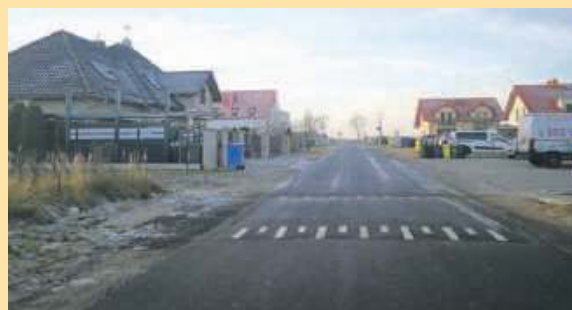
Budowa nawierzchni na ul. Twardowskiego
