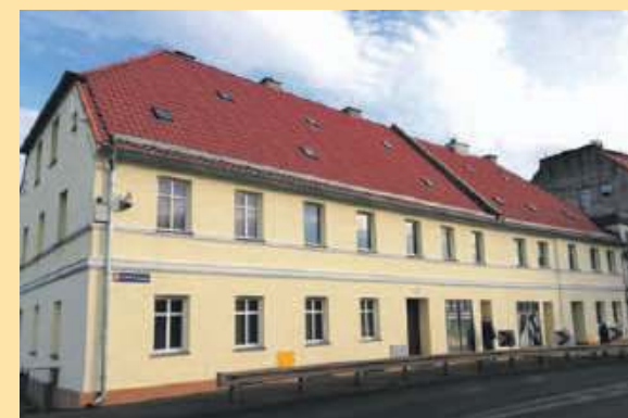
Remont elewacji budynku przy ul. Kutrowskiego 15
