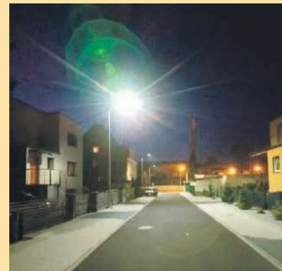
Nowa nawierzchnia i oświetlenie na ul. Rzemieśniczej
