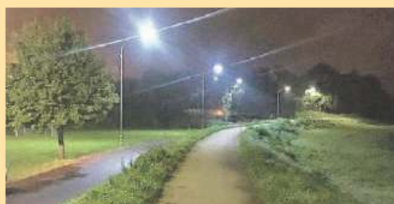
Oświetlenie na wałach wzdłuż rzeki Oławy
