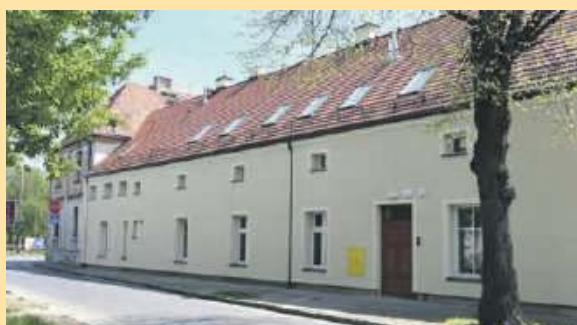
Remont budynku przy ul. Lipowej 20
