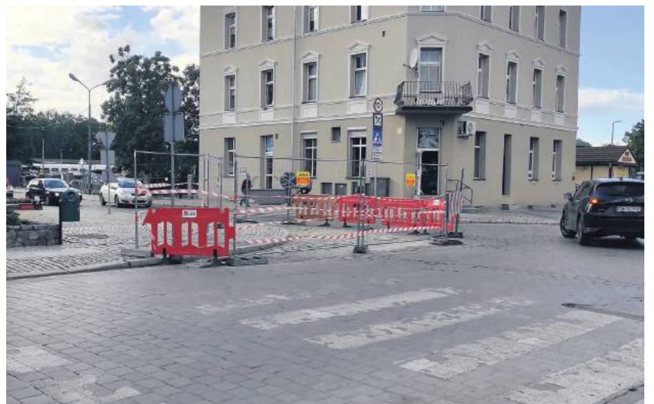
W ubiegłym tygodniu wymieniono przykanalik na skrzyżowaniu ulic Kolejowej i Bolka I Świdnickiego w Strzelinie
